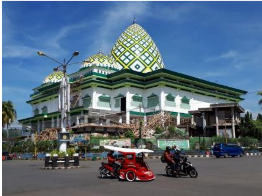
Gambar II.3 Masjid Raya Baitul Makmur Kotamobagu https://kronikotobuan.com/Data/uploads/2017/12/IMG-20171219-WA0007-650x488.jpg (Diakses pada 17/11/2018)
