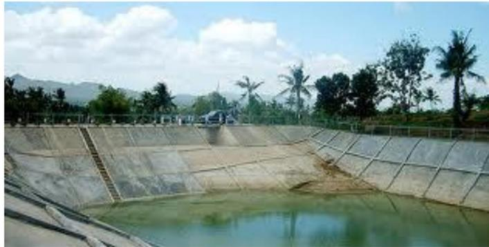
Gambar II.5. Contoh memanen air hujan dengan Embung
