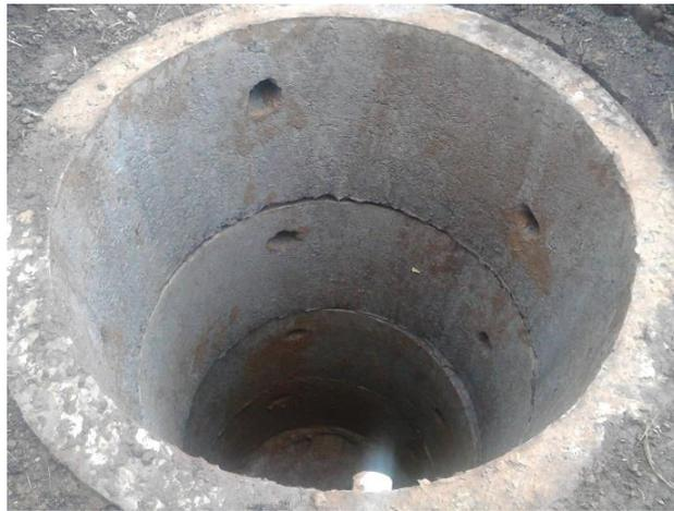
Gambar II.20. Sumur Resapan
