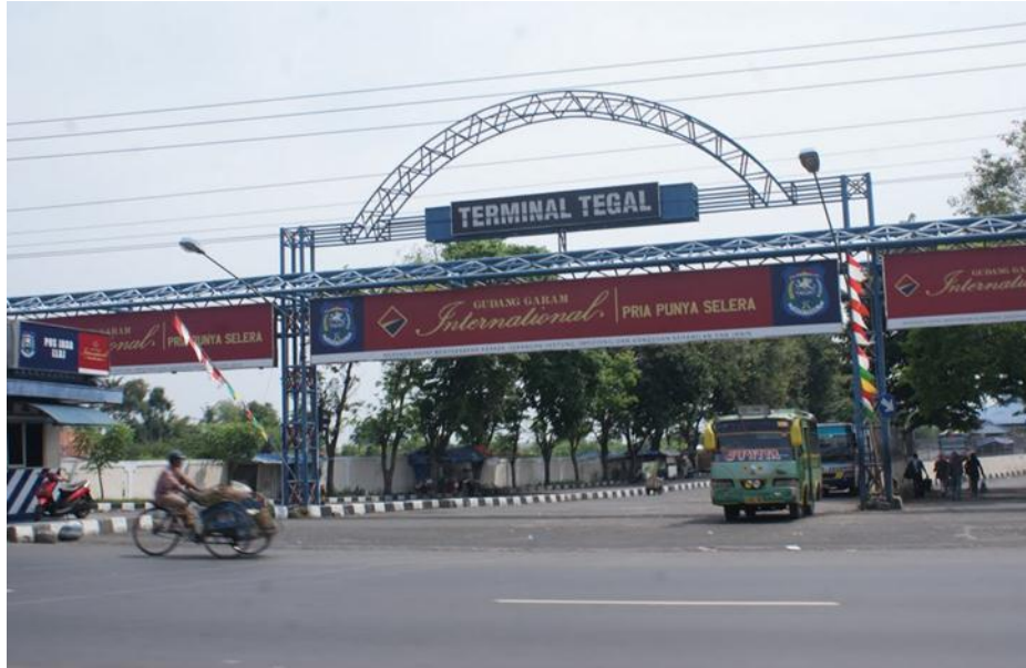
Gambar 1. 1 Bantuan Pembangunan Gapura Terminal Tegal
