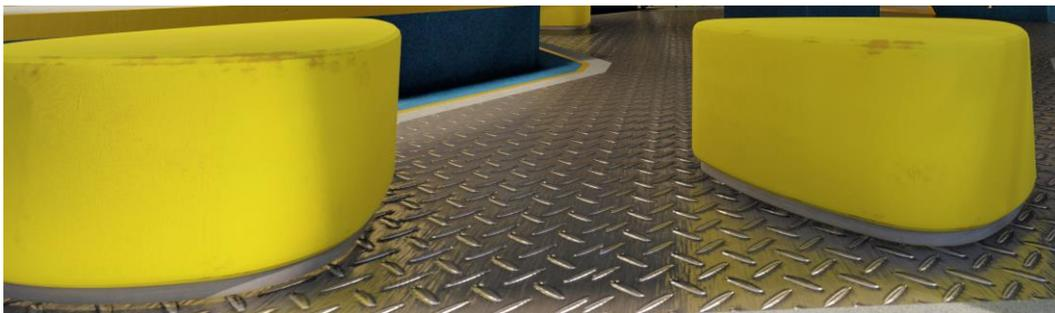
**Gambar 4.23** Contoh bentuk pengaplikasian Konsep Material Alumunium bordsdes pada lantai
