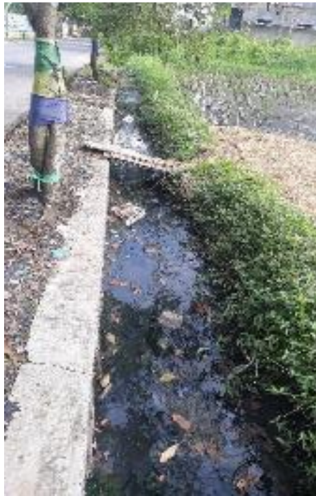
Gambar 1. 3.9 "Drainase" Sumber:"Dokumen Pribadi"
