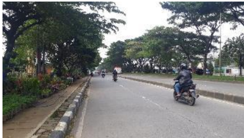
Gambar 1. 3.10 "Drainase" Sumber:"Dokumen Pribadi"
