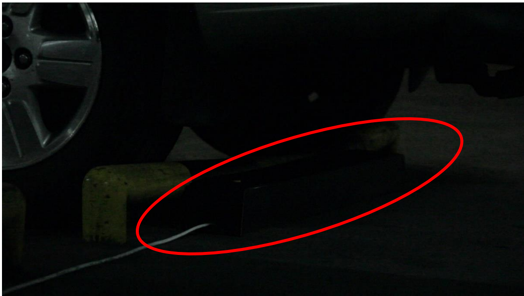
Gambar 4.10. Lampu pada Alat Mikrokontroler Padam
