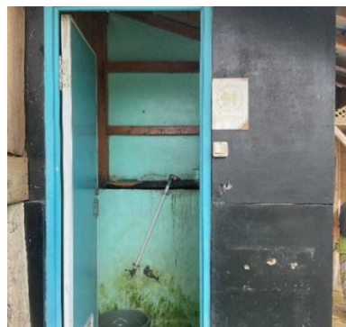
Gambar II.27 Toilet Dekat Mushola Sumber: Dokumen Pribadi (19 Mei 2020)
