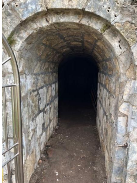
Gambar II.10 Pintu Masuk Bunker Sumber: Dokumen Pribadi (3/01/2024)
