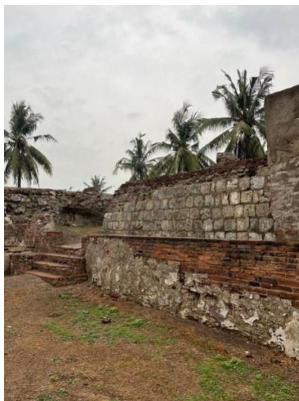
Gambar II.15 Struktur bangunan ruang dapur Sumber: Dokumen Pribadi (3/01/2024)
