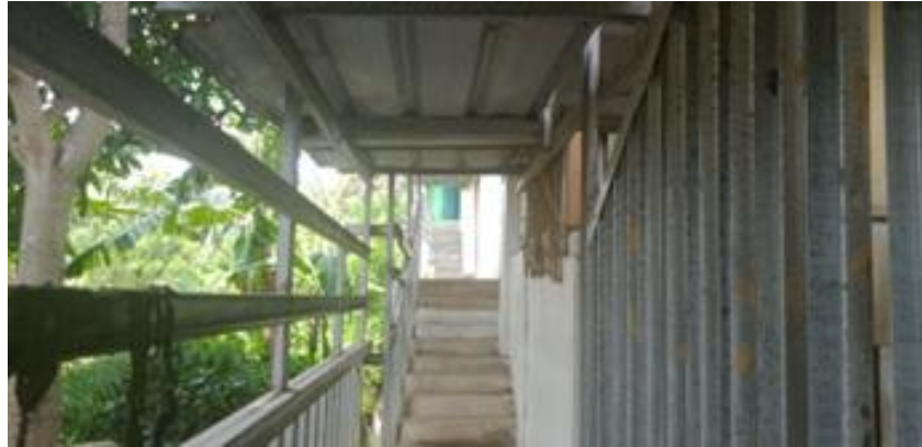
Gambar II.15 gang menuju gedung lain ICC Sumber: Sumber: Dokumentasi Pribadi (2024)
