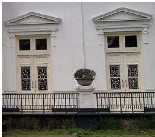
Gambar II. 9 Ornamen pada jendela bangunan yang menggunakan jalusi, penggunaan corak pada bagian atas jendela, dan adanya pagar serambi. Sumber: https://ridwanderful.com (Diakses pada 24/04/2024)
