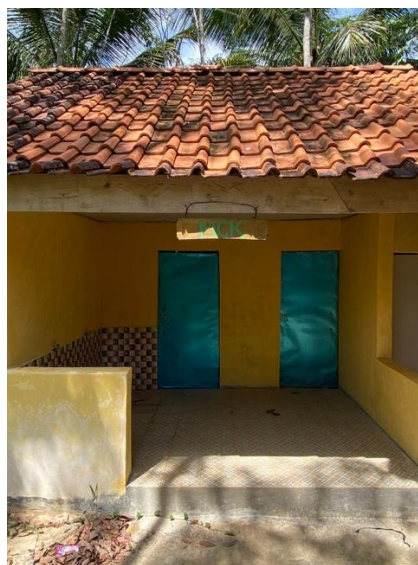
Gambar II.25 Toilet Umum Sumber : Dokumen Pribadi
