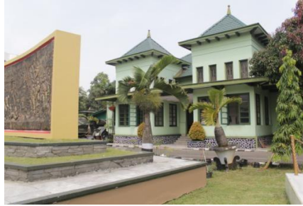
Gambar II. 24 Bangunan museum tampak depan
