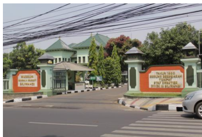
Gambar II. 23 Pintu gerbang utama area museum
