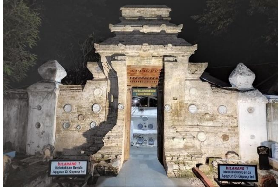
Gambar 2. 50 Gapura Sunan Bonang (Raden Maqдум Ibrahim)
