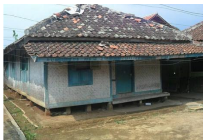
Gambar 2. 20 Bangunan Kampung Adat Mahmud
