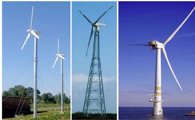
Gambar 6. 5 Berbagai tipe tower sistem pembangkit listrik tenaga angin: Guyed (kiri) Lattice (tengah)- Mono structure (kanan)
