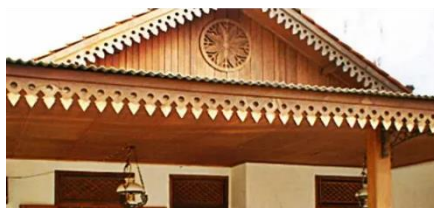
Ukiran bulat dan ketupat atau gigi balang sebagai aksen pada atap dan dinding bangunan
