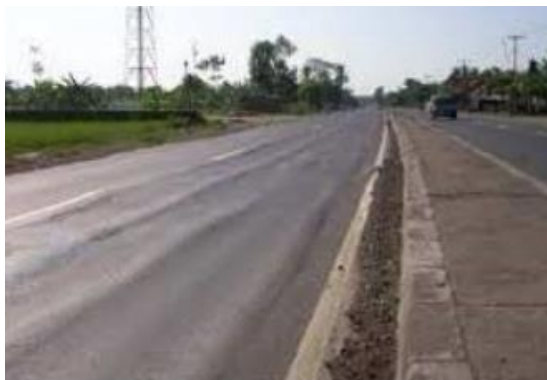
Gambar II. 10 Alur ( Ruts ) Sumber: Dinas PUPR Kab. Kulon Progo
