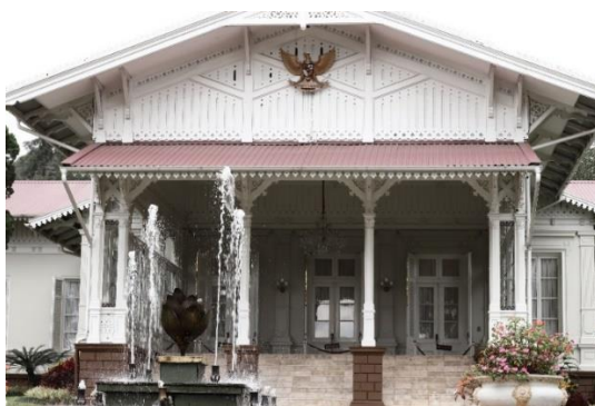
Gambar II.2 Tampak Depan Bangunan Istana Kepresidenan Cipanas Sumber: Dokumen Pribadi (2023)
