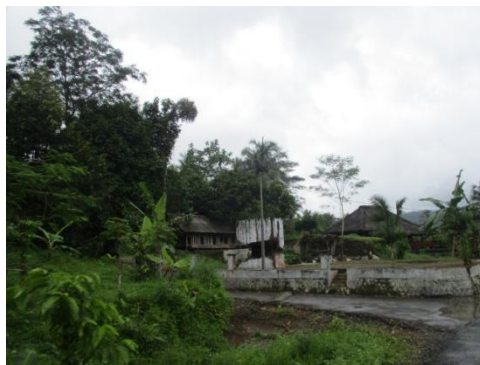
Gambar II.14. Bangunan Rumah Tembok Yang Runtuh Di Kampung Kuta Sumber : Dokumentasi Pribadi (26/11/2022)
