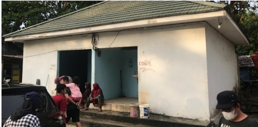
Gambar II. 39 Foto toilet umum Sumber: Dokumen Pribadi (2023)
