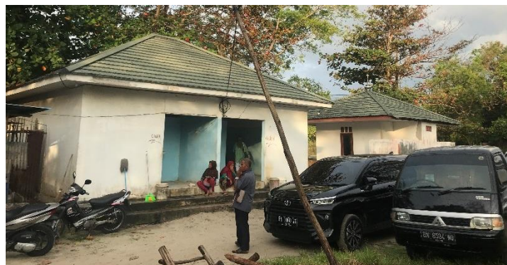
Gambar II. 24 Foto Toilet umum Sumber: Dokumen Pribadi (2023)
