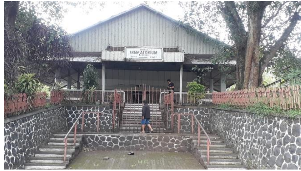
Gambar II.1 Bangunan Yayasan Krematorium Bandung Sumber: Dokumen pribadi (2022)
