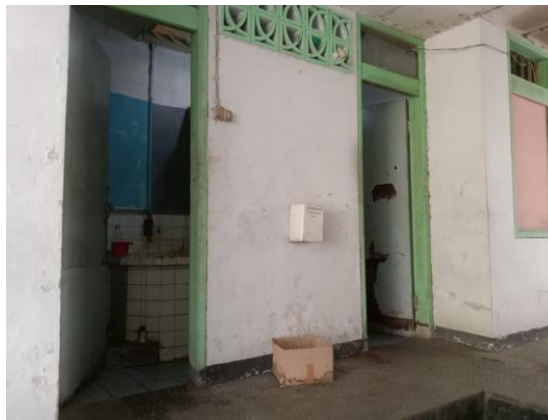
Gambar II.25 Toilet Umum Yayasan Krematorium Bandung Sumber: Dokumen pribadi (2023)
