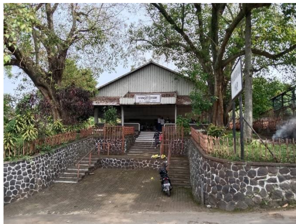
Gambar II.16 Bangunan Yayasan Krematorium Bandung Sumber: Dokumen pribadi (2023)
