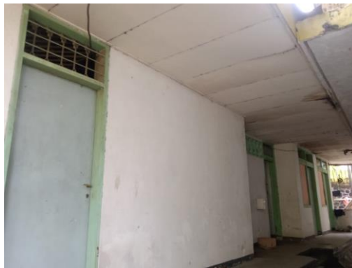
Gambar II.6 Toilet Umum Yayasan Krematorium Bandung Sumber: Dokumen pribadi (2022)
