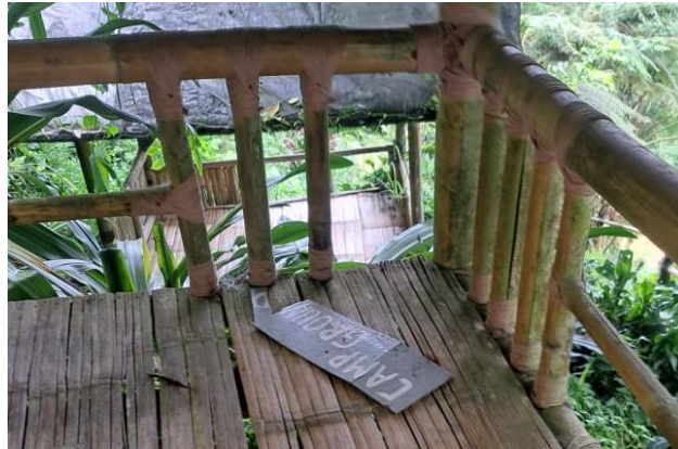
Gambar II.22 Sistem Tanda Yang Sudah Rusak Dan Diletakan Begitu Saja Sumber: Dokumentasi Pribadi (2022)
