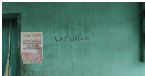
Gambar II. 31 Tulisan Wc Umum di Pasar Induk Cikalongwetan Sumber: Dokumentasi Pribadi (2023)
