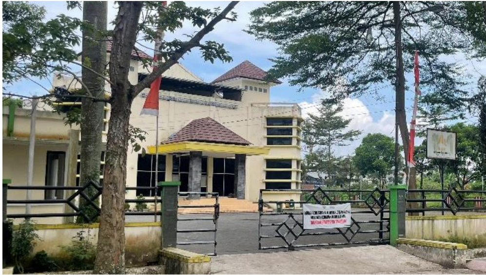
Gambar II.15 Gedung Kesenian Sumber: Dokumentasi Pribadi (2023)
