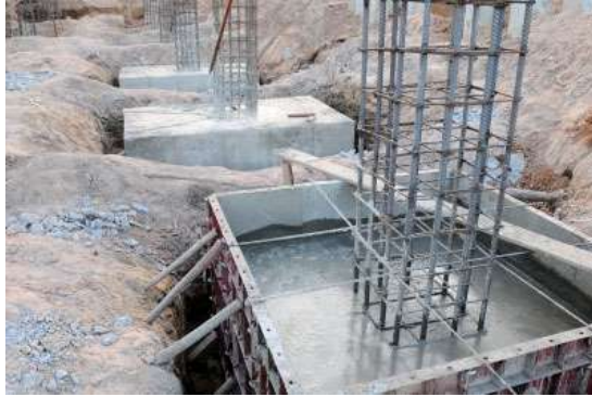
Gambar 5. 16 Struktur Pondasi Telapak
