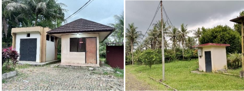
Gambar 5.6. Jaringan Listrik Eksisting Sumber :Doc. Pribadi
