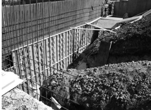
Gambar 2. 1 Dinding Kantilever saat Konstruksi (Braja M. Das, 2011)
