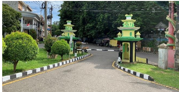
Gambar II.2 Potret Pintu Masuk Utama Menuju Parkiran Benteng Marlborough
