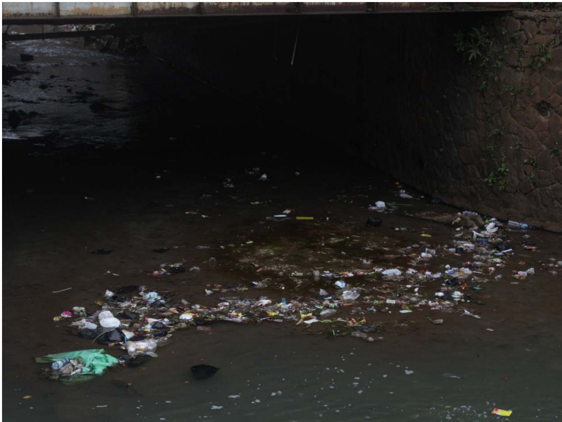
Gambar II.2 Kondisi Sungai Cipamokolan Saat Observasi Sumber : Diambil pada 23 Juni 2022
