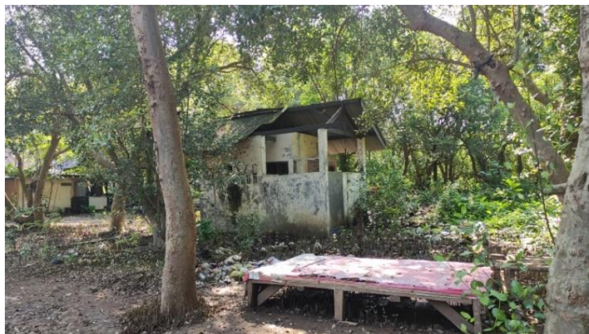
Gambar II.29 Toilet umum yang tidak terpakai lagi Sumber: Dokumentasi Pribadi (2022)
