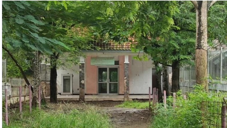
Gambar II.33 Kantor Pengelola Sumber: Dokumentasi Pribadi (2022)
