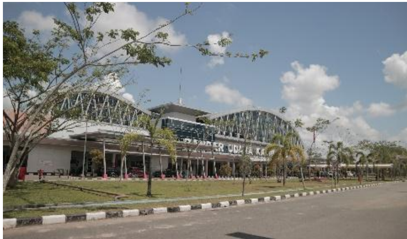
Gambar II.2. Bangunan Bandar udara Kalimantan
