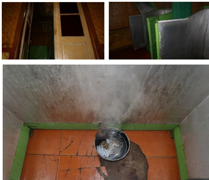
Gambar II.13 Ruangan Utama dan Sumber Uap Sumber: Dokumentasi Pribadi (2022)
