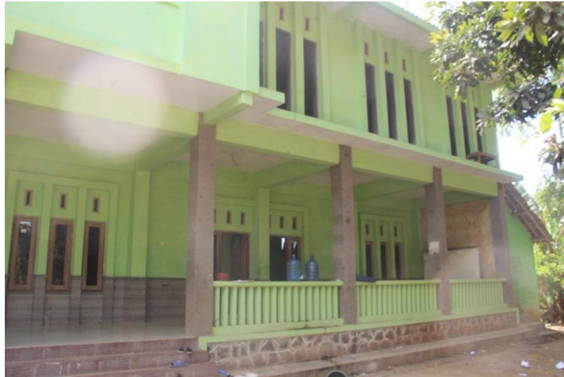
Gambar II.13 Asrama Putra Sumber : Dokumentasi Pribadi (Oktober 2018)
