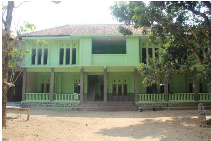
Gambar II.12 Asrama Putra Sumber : Dokumentasi Pribadi (Oktober 2018)
