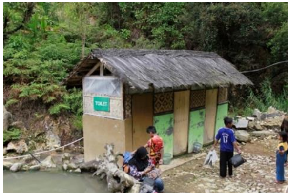
Gambar II.9 toilet umum Sumber: dokumentasi pribadi (2018)
