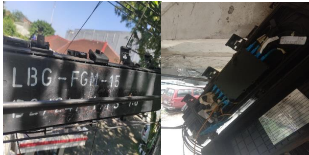
Gambar 2.2 ODP Tipe Closure (Sumber: PT Telkom Witel Bandung)
