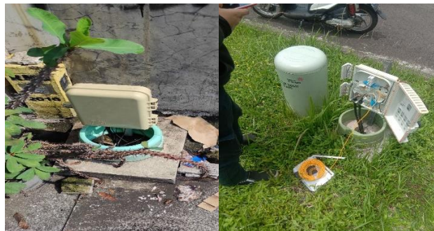
Gambar 2.1 ODP Tipe Pedestal (Sumber: PT Telkom Witel Bandung)
