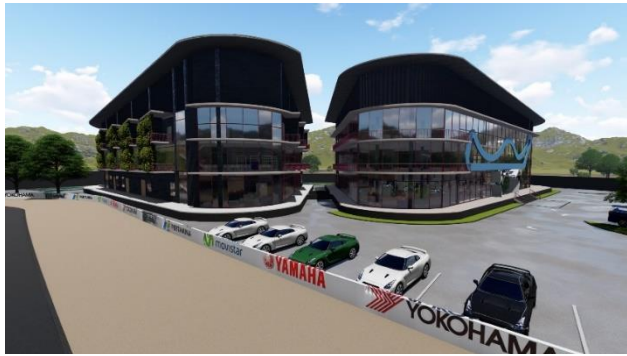
Gambar 6. 32 Suasana Eksterior Bangunan
