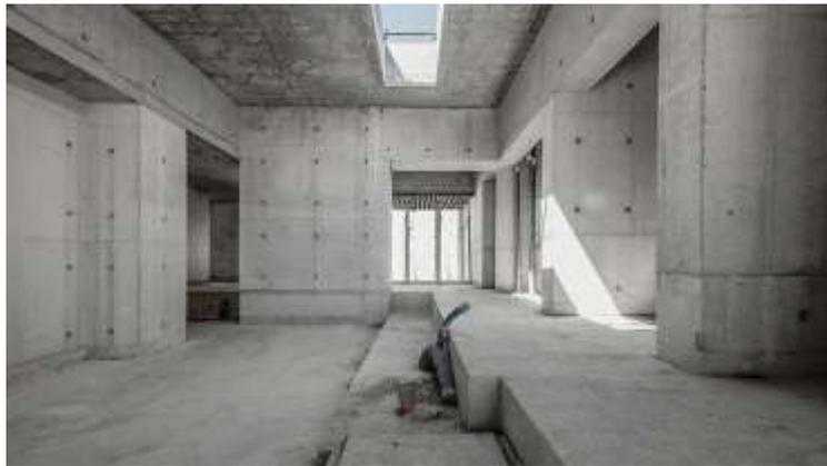
Material utama bangunan merupakan beton sebagai konstruksi bangunan. dan material pabrikan seperti kaca sebagai elemen transparan. Penggunaan material beton juga dapat menjadi sistem penjaga suhu ruangan pada bangunan. Abioso (2008), mengatakan penggunaan material dan konstruksi gedung yang dapat mengatur suhu bangunan merupakan salah satu cara mewujudkan arsitektur daur hidup gedung
