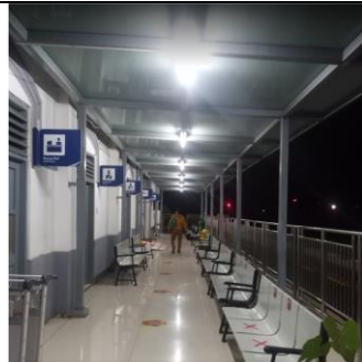
Stasiun purwakarta yang memiliki ruang tunggu yang kecil terlihat sulit untuk sirkulasi dan kurang nyaman
