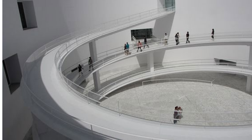
Gambar 5. 19 Penggunaan Ramp sebagai Pencegahan Bahaya Kebakaran
