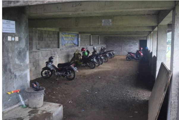
Gambar II.34 Lahan Parkir Sumber : Dokumentasi Pribadi
