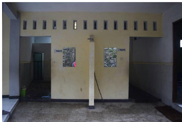
Gambar II.33 WC atau Toilet Sumber : Dokumentasi Pribadi
