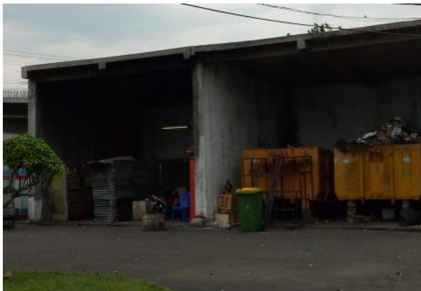
Gambar 2.21 RPH dan pembuangan sampah. Terjadi kendala pada RPH akibat pengusuran pembangunan MRT sehingga RPH berada dekat
