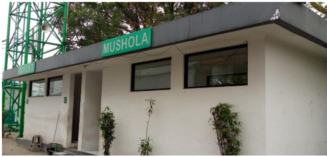
Gambar 2.19 Toilet dan Mushola. Terletak dibagian samping pasar
