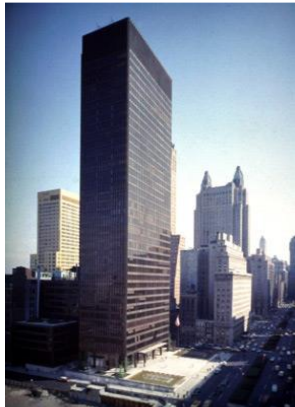
Gambar 4. – Seagram Building , karya salah satu tokoh Arsitektur Modern Ludwig von Mies Van Der Rohe. Salah satu contoh gedung yang merupakan manifestasi ekspresi baru dengan bentuk-bentuk kreatif yang dimungkinkan dengan ditemukannya material-material baru seperti baja, beton bertulang, aluminium, dan kaca dalam dunia teknik, yang sangat kontras dengan material-material yang sudah ada sebelumnya yaitu kayu dan batu.
