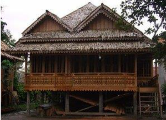
Gambar 3. – Rumah Panggung Palembang. Struktur panggung dirancang dengan berbagai tujuan, salah satunya adalah untuk menanggapi kondisi iklim Tropis Indonesia.
