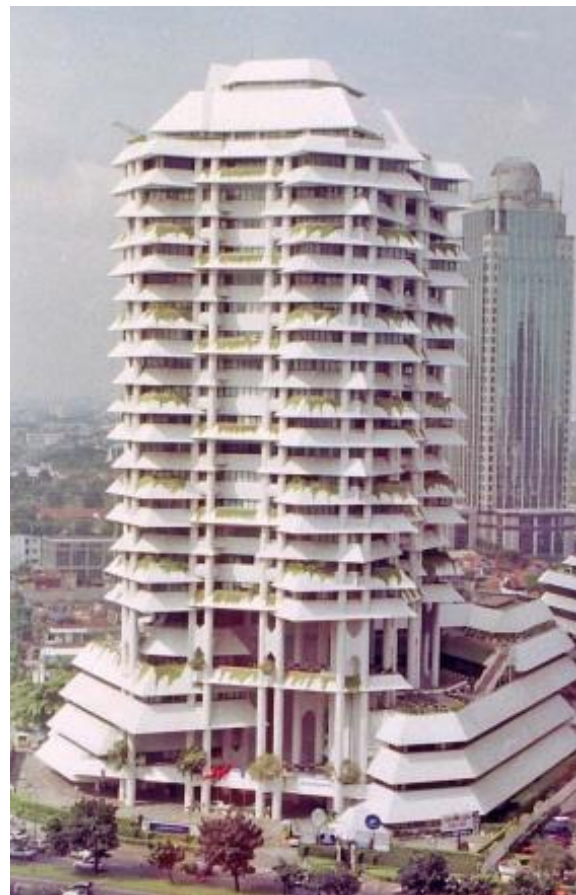
Gambar 10. – Gedung Wisma Dharmala Sakti di Jakarta, gedung berlanggamkan arsitektur Post Modern ini berupaya untuk menerapkan elemen-elemen tradisional arsitektur tropis seperti teritisan yang lebar.
