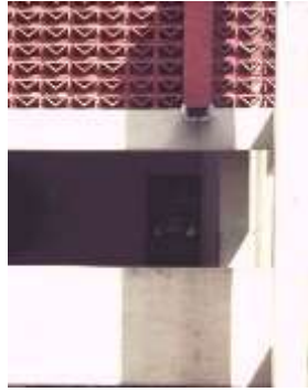
Gambar 5: Dinding terawang dan talang air ( Sumber Foto : Masjid 2000)
