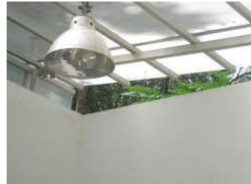
Gambar 14: Sirkulasi udara alami dari atas (sumber: Dewiyanti, 2012)
