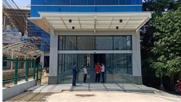
Gambar 2. 14 Bangunan Stasiun KA Bandara Manggarai
