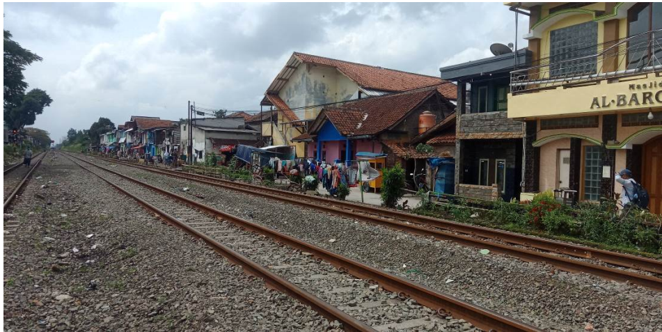
Gambar II.19 Bangunan di Pinggiran Perlintasan Kereta Api Sumber: Data Pribadi
