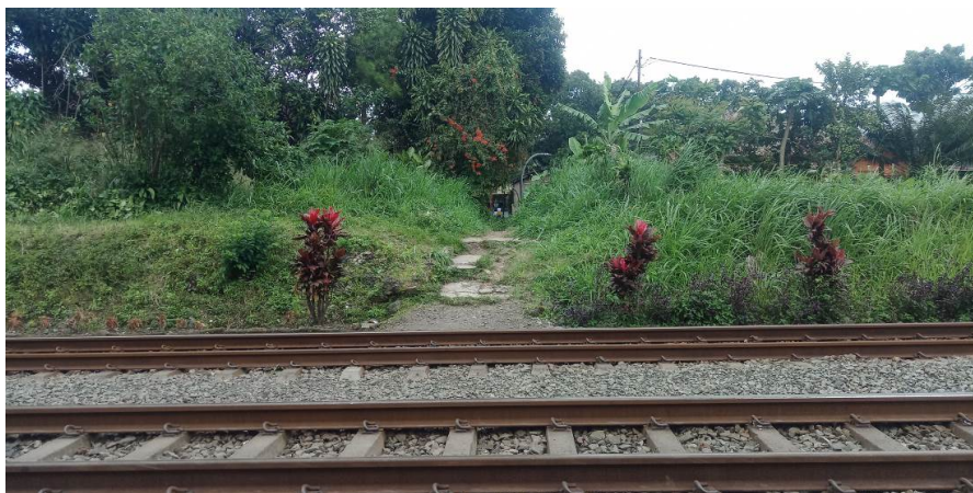
Gambar II.9 Akses Jalan Dekat Pasar
