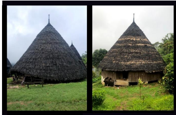
Gambar II.12 Penginapan di Kampung Waerebo Sumber: Dokumen Pribadi
