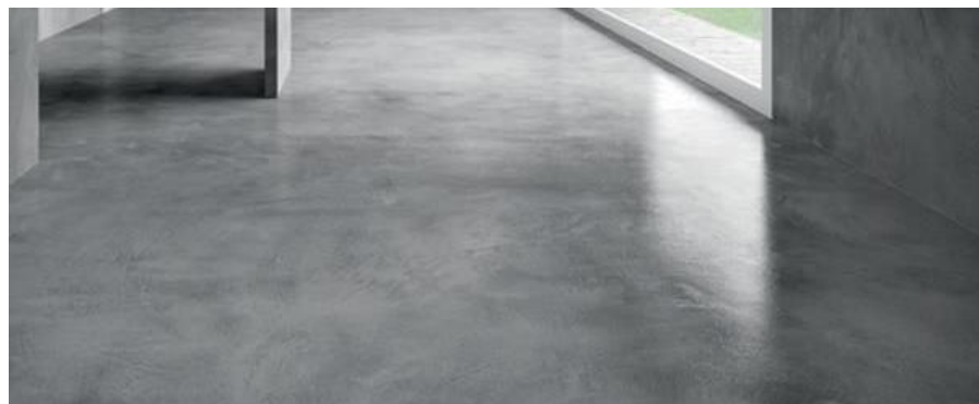
Gambar 5.10 Lantai beton ekspos
