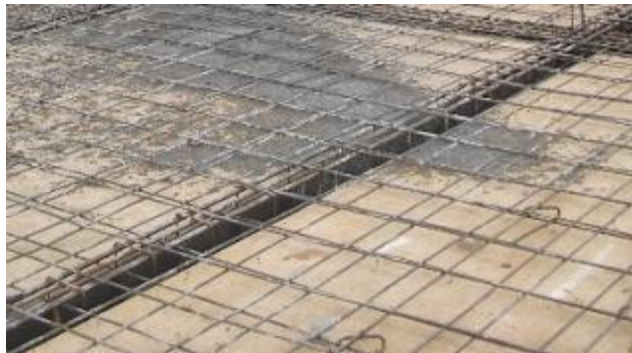
Gambar 2. 2 Pelat Lantai Beton Bertulang
