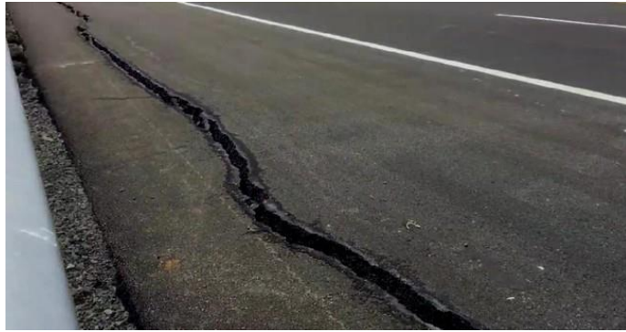
Gambar 2. 7 Retak Samping Jalan
