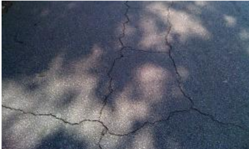
Gambar 2. 3 Retak Kotak-Kotak
