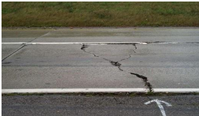
Gambar 2. 8 Retak Sambungan Jalan
