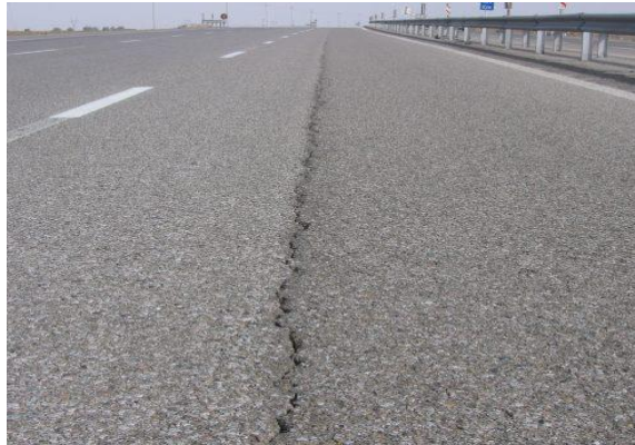
Gambar 2. 9 Retak Memanjang
