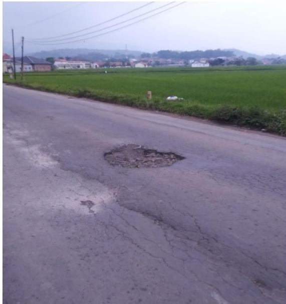
**Gambar 2. 5 lubang pada jalan**
